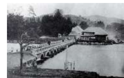
安積疏水開削当時の十六橋水門
